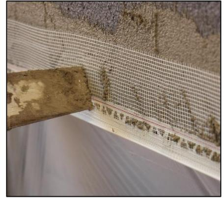
9. Wenn das Ansatzmaterial beim Eindrücken aus den Profillöchern herausquillt, ist der Putzschmel optimal hinterfüllt
