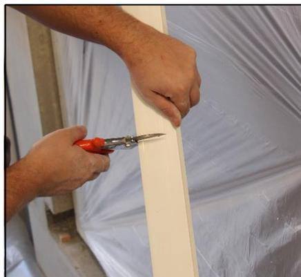
2. Ablängen auf die benötigte Länge. Tipp: Zuerst den Einschubschenkel schneiden...
