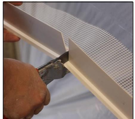
3. ...anschließend den vorderen Profilteil mit einem kräftigen Schnitt durchtrennen
