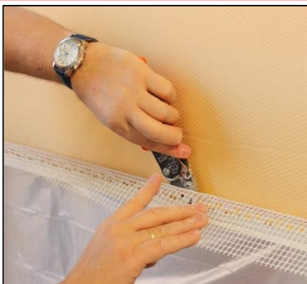
10. Das Profil 37946 mit geeignetem Hilfsmittel entlang der gesamten Stablänge andrücken
