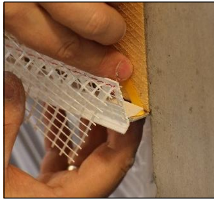
8. Den Abdeckliner nach oben wegziehen und Profil 37946 ansetzen
