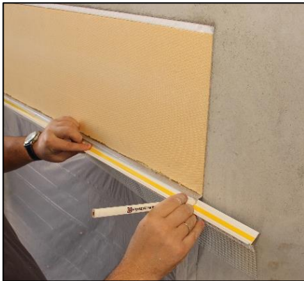
1. Profil 37946 anzeichnen oder einmessen
