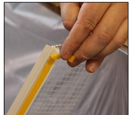
6. Den überstehenden Abdeckliner zu einer Schlaufe legen
