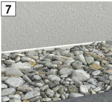
**7** Danach Anschüttung der Kiesdrainage bis zur Profilerkante.
