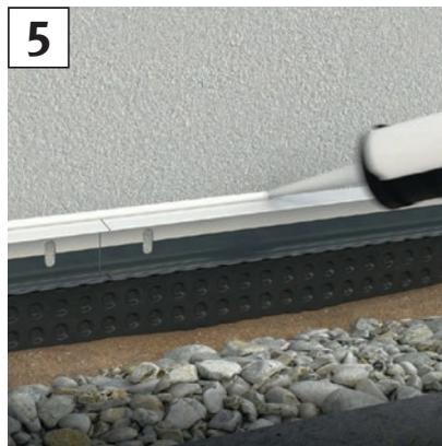
**5** Die Fuge zwischen Alu-Grundprofil 90527 und Untergrund kann mit dem geeigneten Dichtstoff, z.B. Protektor 1455 in weiß oder Protektor 1456 in anthrazit (Tremco-Ilbruck SP 525) ausgefugt werden. Dazu den Klebdichtstoff in Fugenbreite auflegen und innerhalb der Hautbildungszeit (max. 30 Minuten) glätten.
