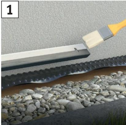
**1** Primer auf Rückseite des zweifarbigen Alu-Grundprofils Protektor 90527 mit einem sauberen Pinsel oder Lappen dünn auftragen. Danach mind. 15 min Abluftzeit einhalten (max. 8 Stunden).
