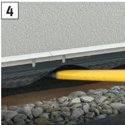
**4** Nach ca. 1 Tag Trocknungszeit die Noppenbahn entlang der Unterkante des Profils 90527 ungefähr bündig abschneiden.
