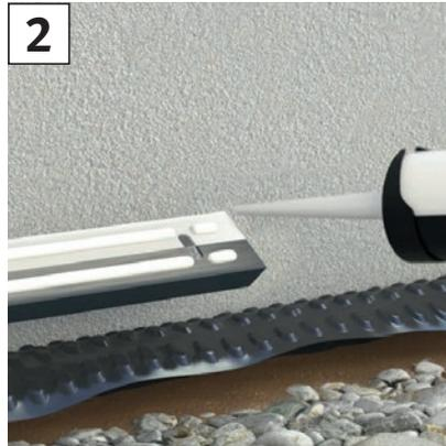
**2** Auf der Rückseite des Grundprofils 90527 zwei parallel verlaufende geradlinige Kleberrauten (jeweils ca. 5 mm breit in Abhängigkeit von der Untergrundbeschaffenheit) auftragen.
