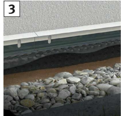
**3** Das Grundprofil 90527 mit der Oberkante entlang der GOK ansetzen und fest andrücken. Das Profil kann je nach Wunsch mit der weißen oder mit der anthrazitfarbenen Fläche nach oben angeklebt werden. Am Stoß der Einzelstäbe einem Abstand von 1 - 2 mm belassen.
